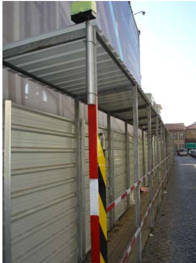
Fig. 36 – Exemplo de ocupação da via pública durante a realização de obras de reabilitação
