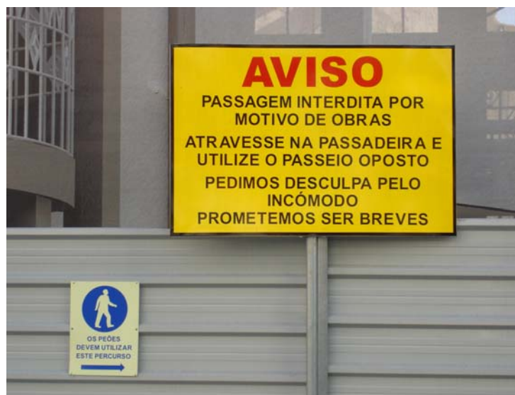
Fig. 35 – Exemplo de interferência de obras de reabilitação com os cidadãos
