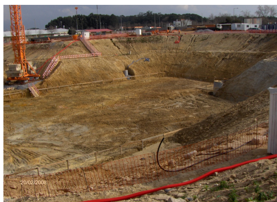
Fig. 6.1 Vista geral da escavação efectuada num dos corpos do empreendimento habitacional
