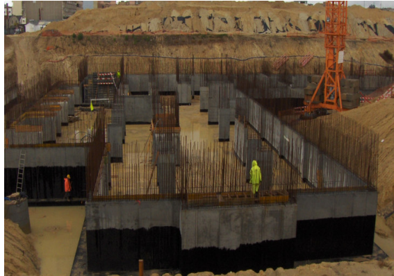
Fig. 6.2 – Vista geral do empreendimento habitacional objecto de monitorização, já na fase de fundações e estruturas, incluindo o aterro de fundações
