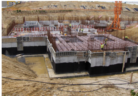
Fig.6.3 – Vista geral da parte Oeste do empreendimento habitacional
