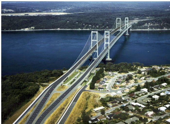
Fig. 2.2 – Imagem aérea da ponte Tacoma Narrows, nos Estados Unidos da América, onde foi aplicada com sucesso a abordagem CAS
