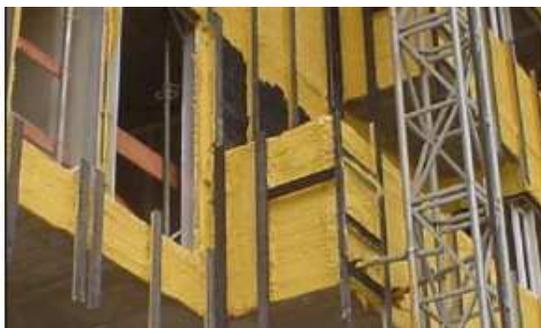
Fig.14 – Colocação do Isolamento [ 34 ]
