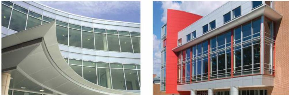
Fig.7 – Edifícios com revestimento em placas de alumínio composto [32]
