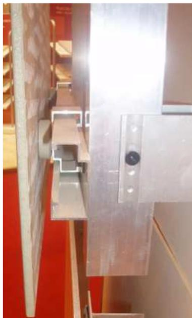
Fig.11 – Sistema de acoplamento oculto aplicado no tardo de uma placa de grés porcelânico [12]
