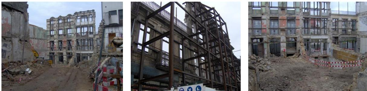
Fig. 119 - Fase de demolições e contenção de fachada (Março a Junho de 2007)
