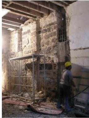
Fig. 102 - Construção dos pilares de betão-armado escastrados nas paredes
