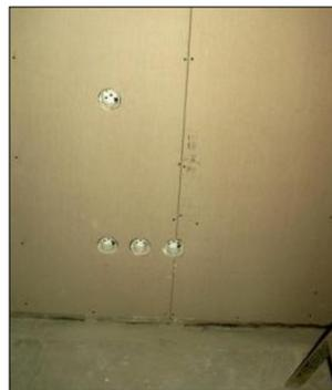
Fig. 40 - Em fase de execução - pormenor de tomadas eléctricas em paredes divisórias
