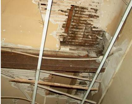
Fig. 18 - Existência pontual de vigas metálicas de reforço estrutural apoiando nas paredes da caixa de escadas e nas paredes da envolvente - tecto do 2º piso
