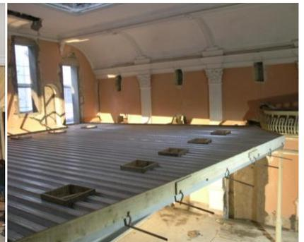
Fig. 98 - Preparado para receber o betão levemente armado (12cm)
