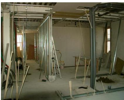
Fig. 51 - Execução de paredes divisórias e instalações
