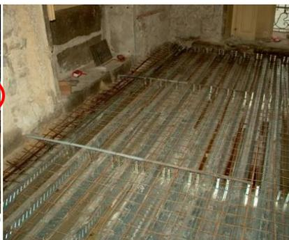
Fig. 49 - Pormenor de construção dos pavimentos semi-leves com recurso a chapa colaborante
