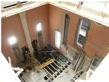
Fig. 86 - Fase de execução - desmonte do pavimento do salão
