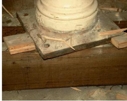
Fig. 70 - Viga de madeira que evidenciava empeno, torção e esmagamento de fibras
