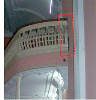
Fig. 71 - Descolamento do balcão em relação à parede devido à rotação do pilar metálico de apoio
