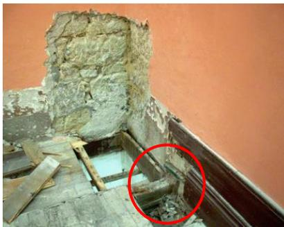
Fig. 72 - Vista dos reconhecimentos efectuados - pormenor de ligação pavimentos/paredes (gateamento metálico)
