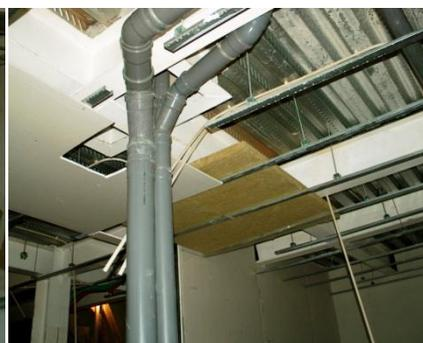
Fig. 52 - Pormenor de infra-estruturas hidráulicas e isolamento sob tecto falso
