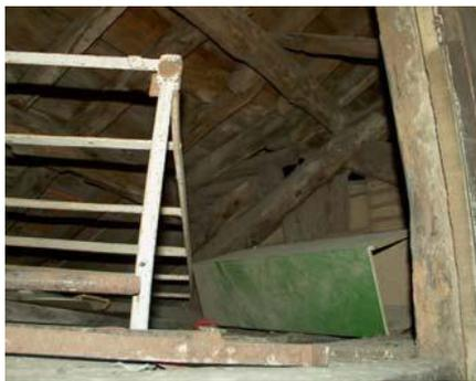
Fig. 20 - Estrutura da cobertura em mau estado de conservação - demolição prevista pelo programa
