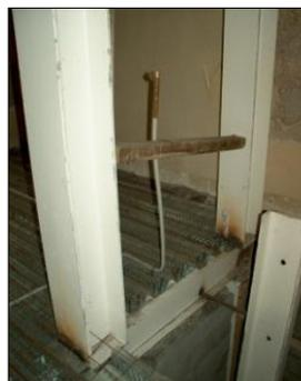
Fig. 34 - Em fase de execução - vista da rede de gás sobre chapa colaborante
