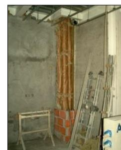
Fig. 36 - Fase de execução - courettes técnicas
