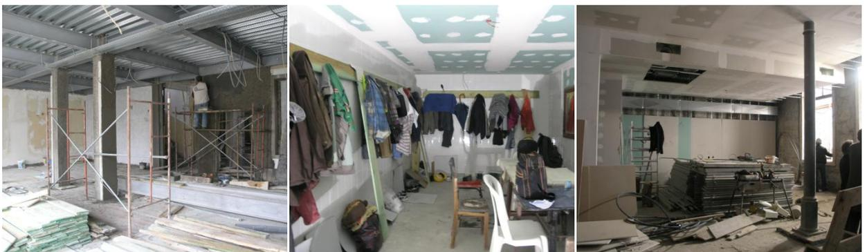
Fig. 105 - À esquerda reconstrução de laje com recurso a chapa colaborante e ao centro e à direita exemplo de organização de estaleiro em obra (instalações e armazém no interior do edifício)
