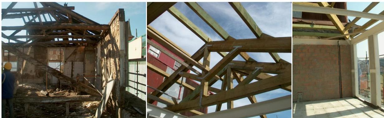
Fig. 54 - Demolição de recuado e posterior reconstrução de cobertura em madeira e estrutura com perfis metálicos
