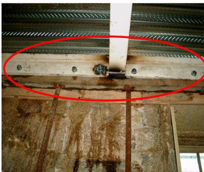
Fig. 48 - Pormenor de ligação de pavimentos à parede com recurso a "parafusos" funcionando como tirantes
