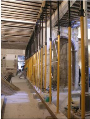
Fig. 101 - Escoramento provisório para demolição de parede mestra
