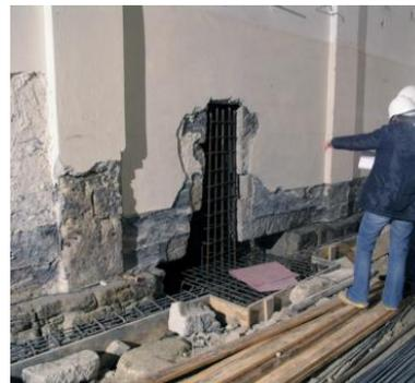
Fig. 84 - Fundações dos pilares encastrados na parede
