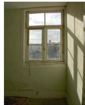
Fig. 21 - Pormenor de caixilho degradado e empenado no recuado
