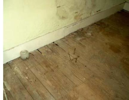
Fig. 19 - Pavimento do piso recuado (constatou-se a existência de flechas excessivas em todos os pisos)
