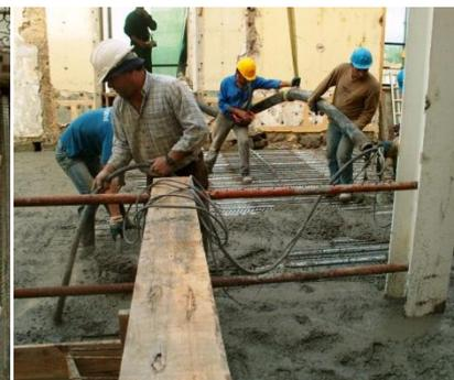
Fig. 50 - Betonagem de laje de pavimento
