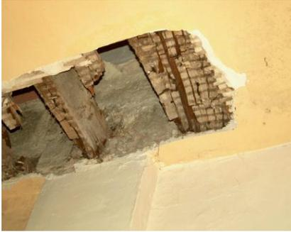
Fig. 69 – Vista de viga de apoio a pilar metálico com entrega atacada por fungos de podridão
