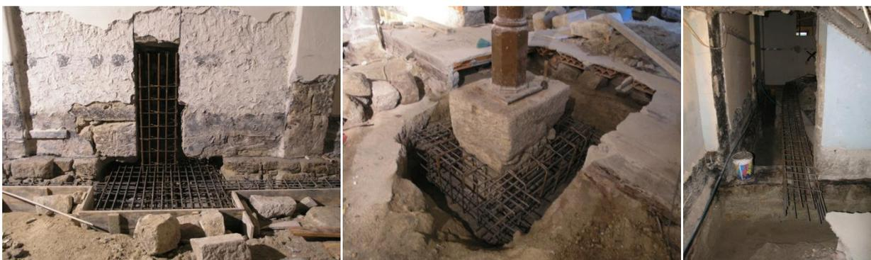
Fig. 85 - Pormenores de reforços efectuados - fotografias do piso térreo (fase de execução)
