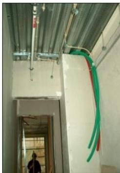
Fig. 39 - Em fase de execução - instalações eléctricas sobre tecto falso
