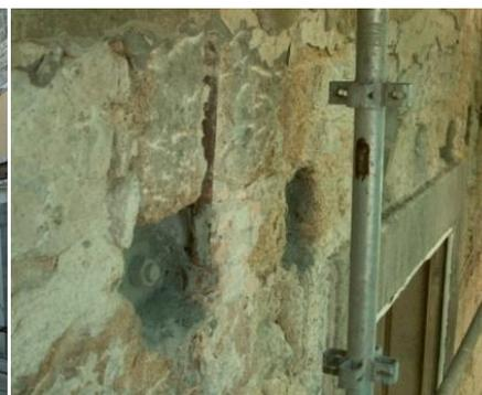
Fig. 47 – Fixação do pavimento à parede (vista pelo exterior)
