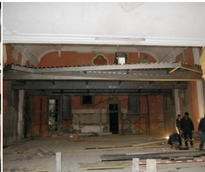
Fig. 97 - Colocação da chapa metálica
