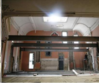
Fig. 94 - Colocação dos três perfis metálicos
