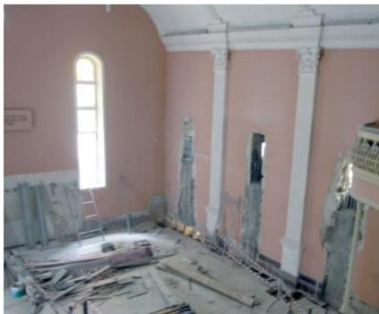
Fig. 83 - Novos pilares de betão armado – para suporte mezzanine
