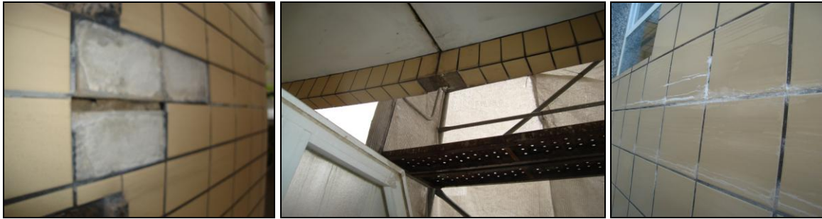
Fig. 46 - Destaque de cerâmicos. Destaque de cerâmicos na junta de dilatação. Formação de Babados.
