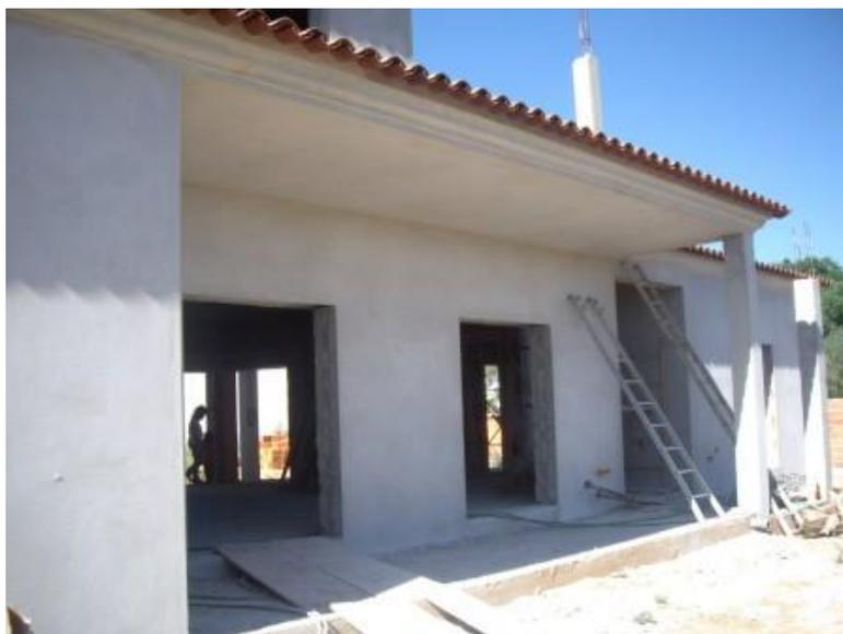
Figura 17 – Pintura exterior sobre reboco [126]
