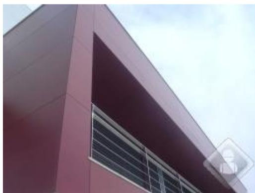
Figura 20 – Exemplo de aplicação de painel fenólico (HPL) para exterior [129]
