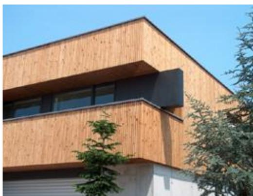
Figura 21 – Exemplo de aplicação da madeira modificada termicamente [130]
