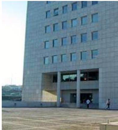
Figura 24 – Fachada ventilada revestida a pedra natural (granito) aplicada na FEUP [133]
