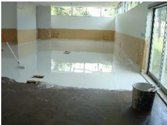
Figura 32 – Pavimento autonivelante [139]
