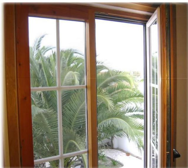
Figura 44 – Exemplo de aplicação de caixilharia em madeira [158]
