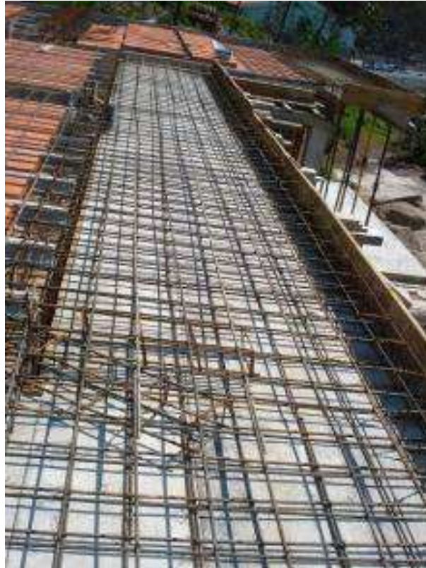
Figura 5.68 - Pormenor da Armadura de Aço
