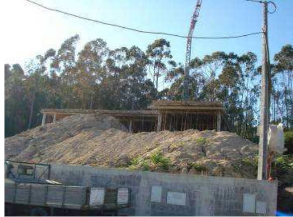
Figuras 5.70 e 5.71 - Escoramento e Cofragem de Elementos Estruturais
