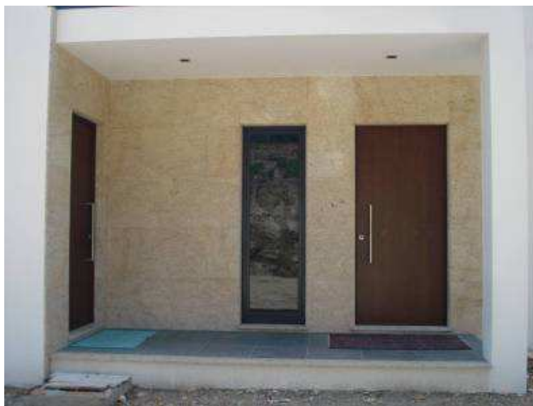
Figura 5.89 - Entrada Principal com Paredes Revestidas a Pedra
