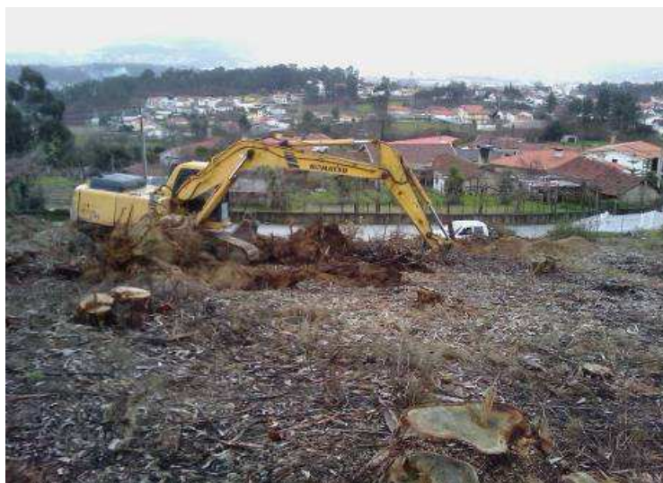
Figura 5.62 - Desmatação e Limpeza do Terreno
