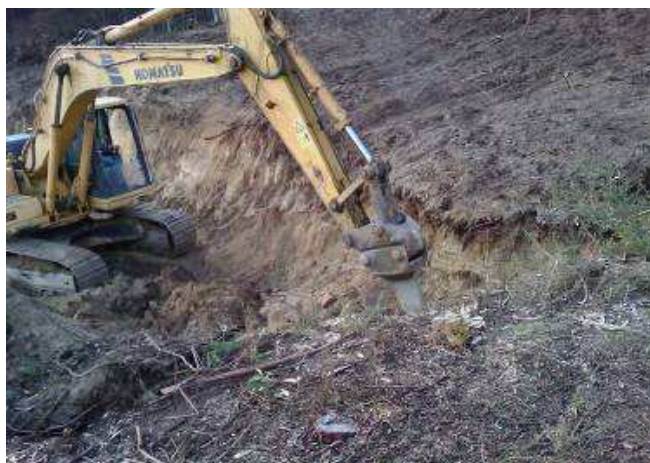
Figura 5.58 - Pormenor do Desnível do Terreno
