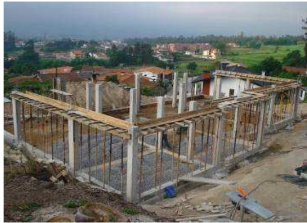
Figura 5.72 - Escoramento e Cofragem de Elementos Estruturais
