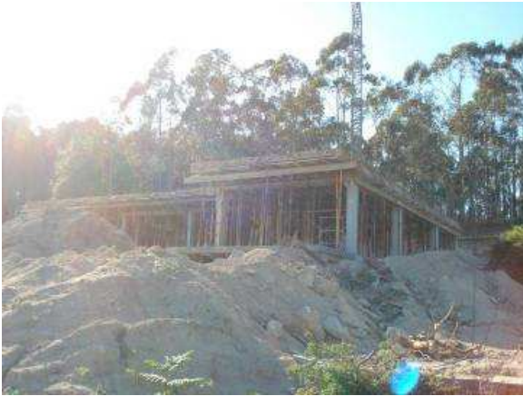
Figuras 5.70 e 5.71 - Escoramento e Cofragem de Elementos Estruturais
