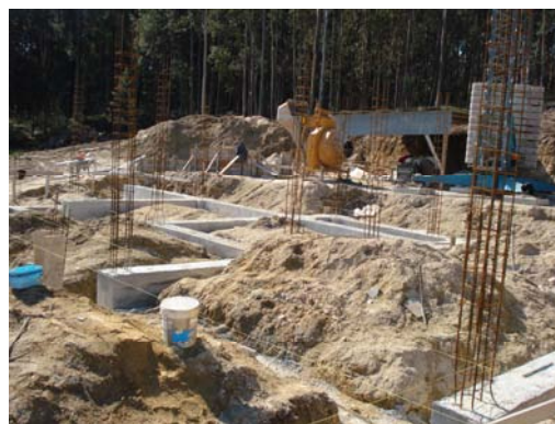
Figuras 5.66 e 5.67 – Elementos de Fundação
