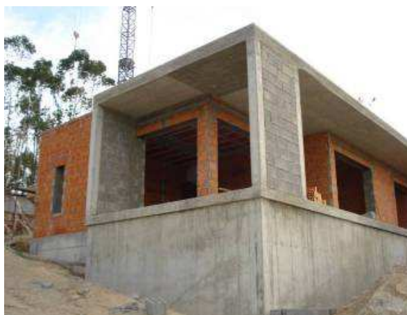
Figura 5.74 - Alvenaria em Tijolo
