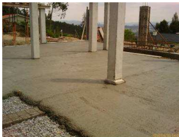
Figura 5.73 - Processo Construtivo da Laje de Pavimento Térreo
