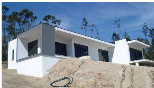
Figura 5.78 – Moradia - Pinturas Exteriores
