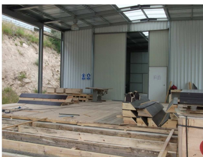
Fig. 21 – Carpintaria de um Estaleiro de Obra (MSF, 2011)
