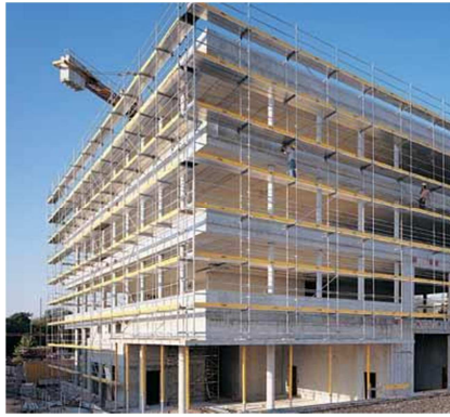
Fig. 15 - Andaimos para apoio à realização dos trabalhos
