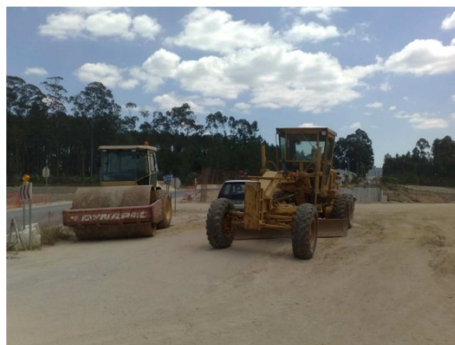
Fig. 29 - Parque de Equipamentos Móveis
