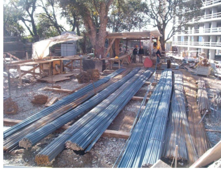
Fig. 26 - Depósito de Armaduras
