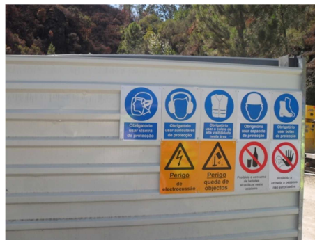
Fig. 16 – Sinalização utilizada em obra
