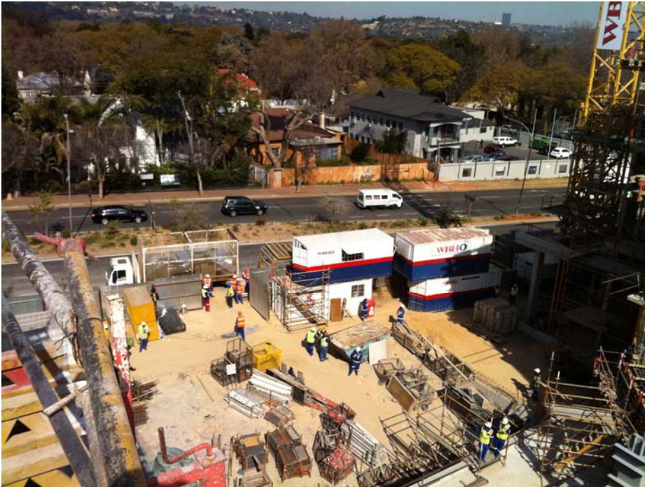
Fig.22 – Zona de carga e descarga
