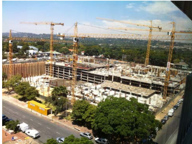
Fig.9 – Foto a partir das instalações de apoio - controle
