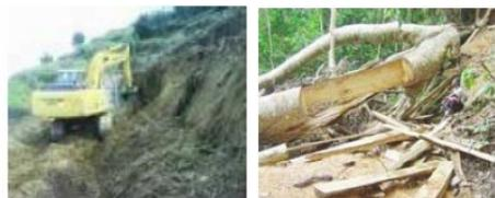
Fig. 22 – Procedimentos de limpeza do terreno
