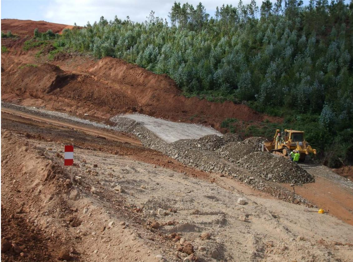
Figura 20 - Fotografia referente a prisma de enrocamento.
