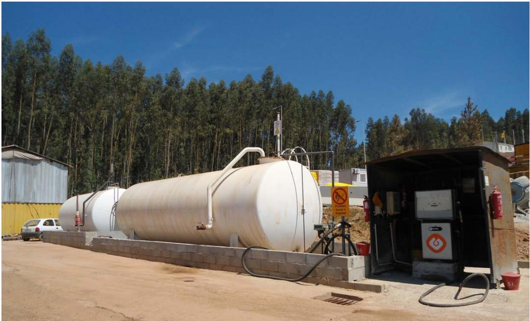
Figura 4 - Fotografia ilustrativa de instalação própria para reservatório de armazenagem e abastecimento de gasóleo.
