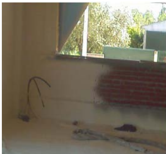
Fig.7.75 – Isolamento térmico formado por espuma de poliuretano projectado [37] [57]
