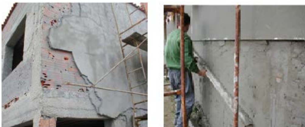
Fig.7.61 – Exemplo de revestimentos iniciais paredes exteriores [38]
