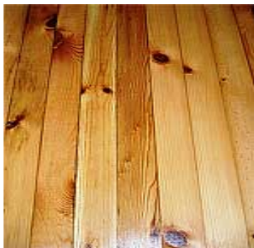
Fig.7.10 – Exemplo de soalho tradicional sobre ripas [41]
