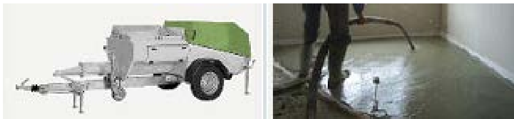
Fig.7.7 – Argamassa Autonivelante aplicação mecânica com misturadora-bombeadora [37]
