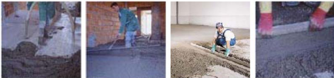
Fig.7.5 – Sequência de aplicação de uma argamassa de pavimento [38]
