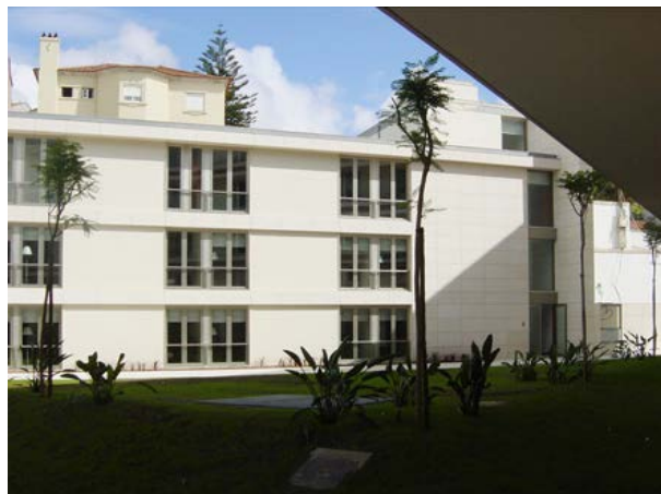
Fig.6.4 – Fotografia da Fachada do núcleo 3 virada a Oeste [33]
