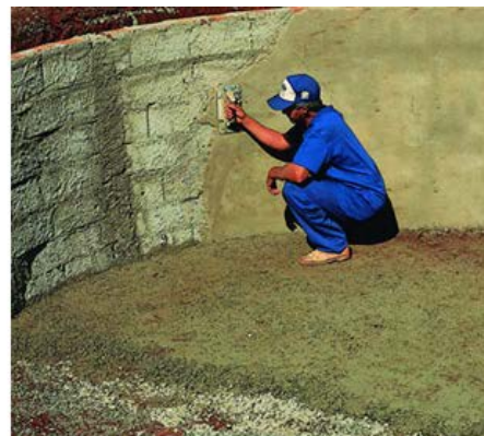
Fig.7.47 – Exemplificação de emboço/reboco [53]
