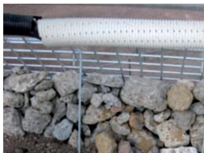
Fig. 29 - Muro gabião parcialmente cheio protegido com condutas modificadas [52]
