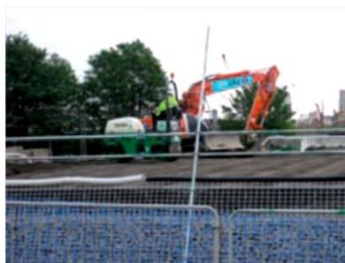
Fig. 30 - Extremidades do arame protegidas com condutas [52]
