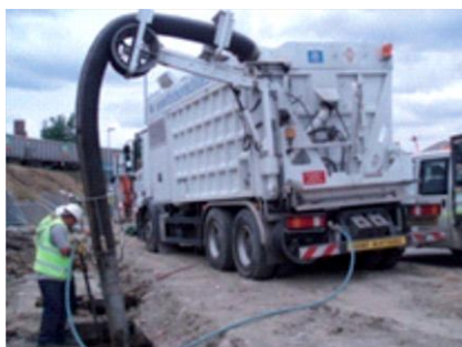
Fig. 34 - Operação de escavação por sucção [56]
