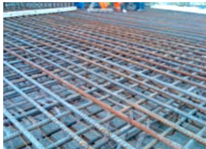
Fig. 38 - Uso da malha D49 no reforço de aço. [59]
