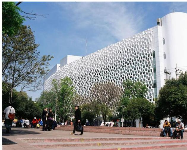
Figura 12 - Fachada Prosolve370e. Usa nanopartículas de TiO<sub>2</sub> para combater a poluição atmosférica. Site da Elegant Embellishments Ltd.
