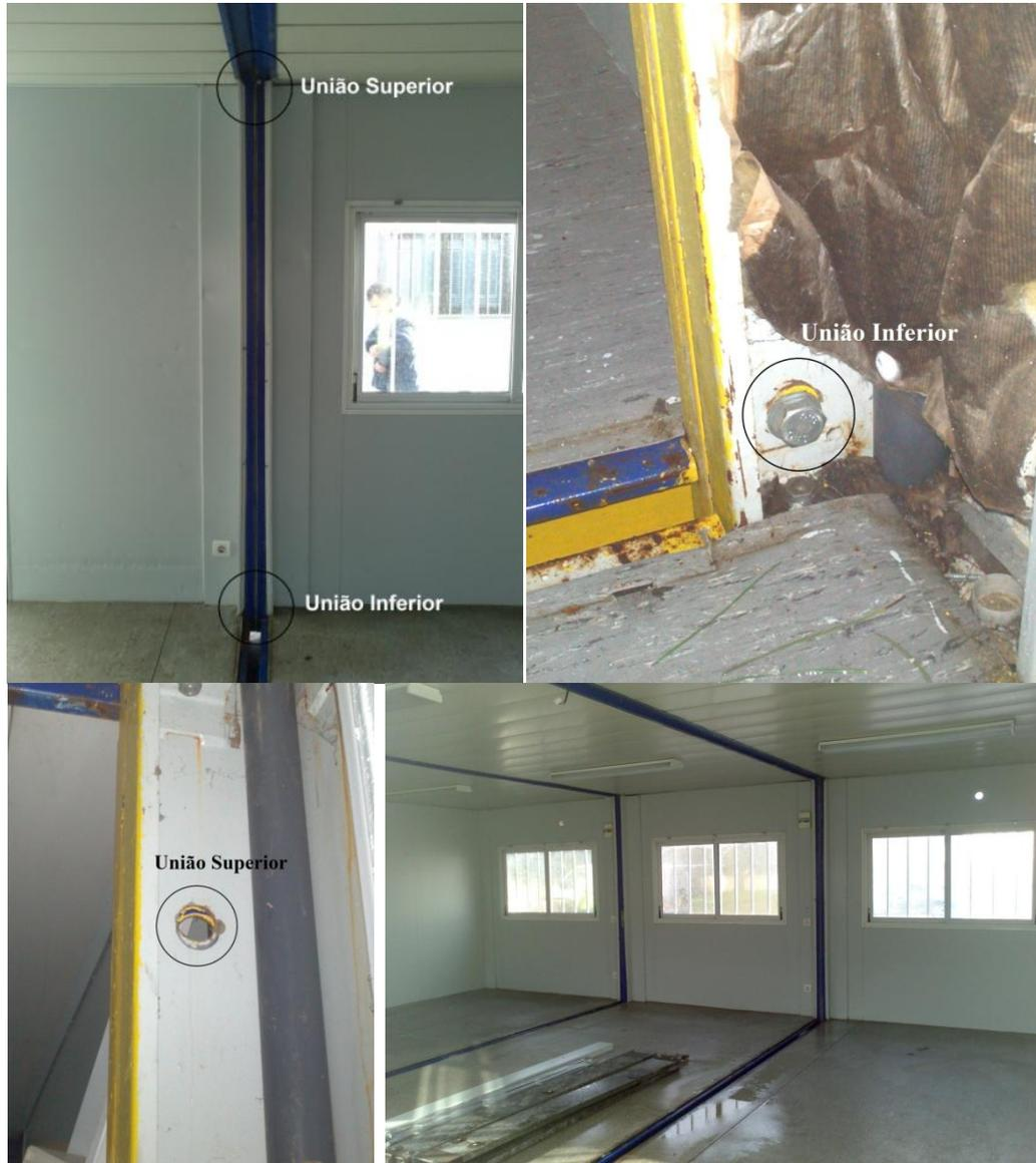
Fig. 30 – Exemplo de acoplamento de módulos
