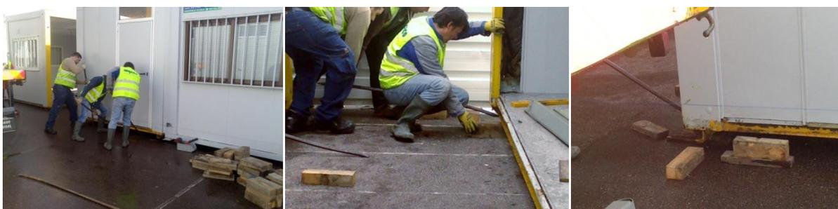
Fig. 29 – Exemplo do nivelamento vertical por meio da utilização de calços de madeira
