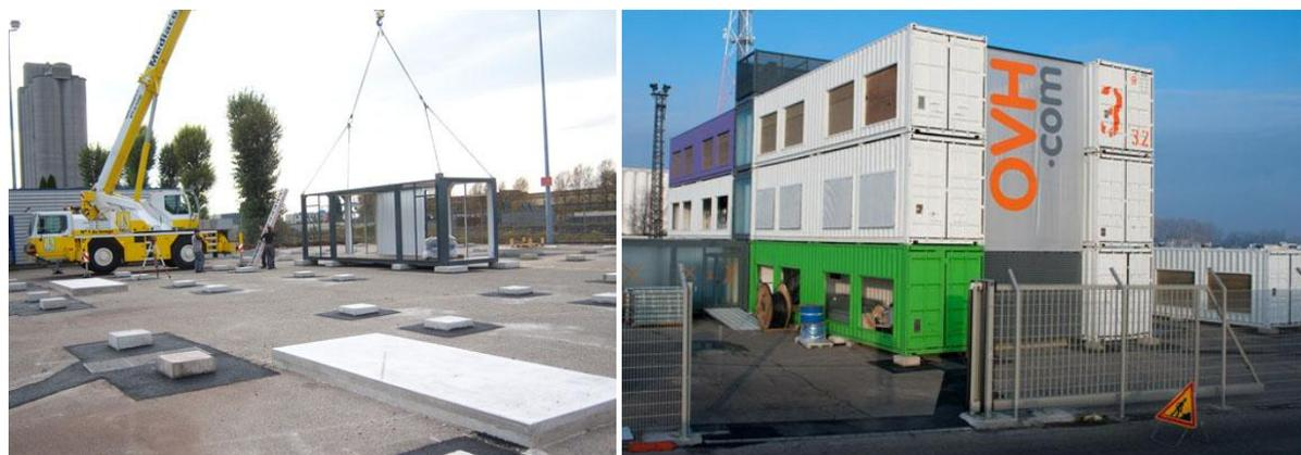
Fig. 12 – À esquerda, colocação dos contentores sobre as fundações; à direita, estrutura após conclusão [26]
