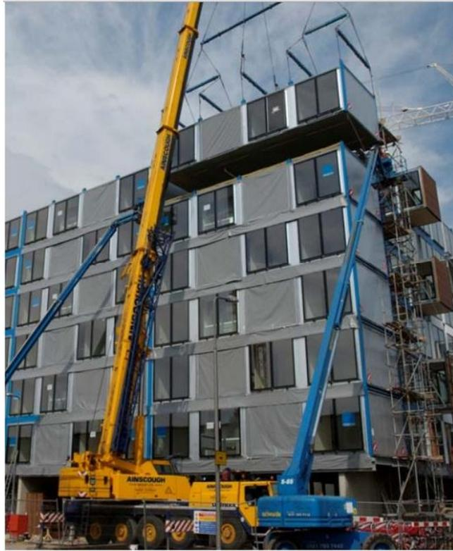
Fig. 9 – Posicionamento de um módulo [22]
