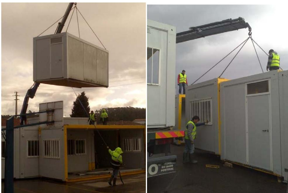
Fig. 28 – Elevação (á esquerda) e posicionamento de um módulo (á direita)
