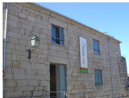
Figura 2.9 - Edifício recentemente intervenido
