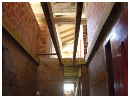
Figura 2.10 - Edifício em fase de intervenção
