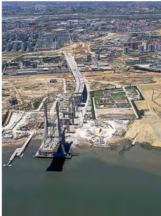
Figura 14 - Ponte Vasco da Gama em construção
