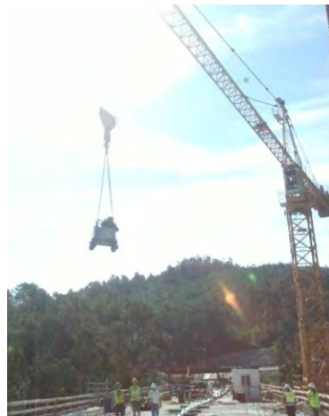
Figura 82 – Transporte do macaco hidráulico
