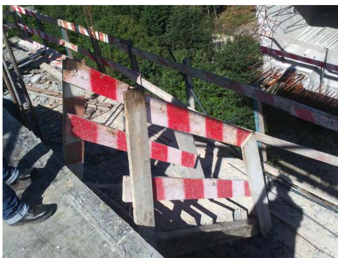
Figura 54 - Escada de acesso à plataforma de trabalho superior
