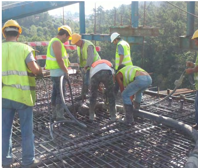
Figura 75 - Sobre-esforços e posturas inadequadas no transporte da manga de descarga
