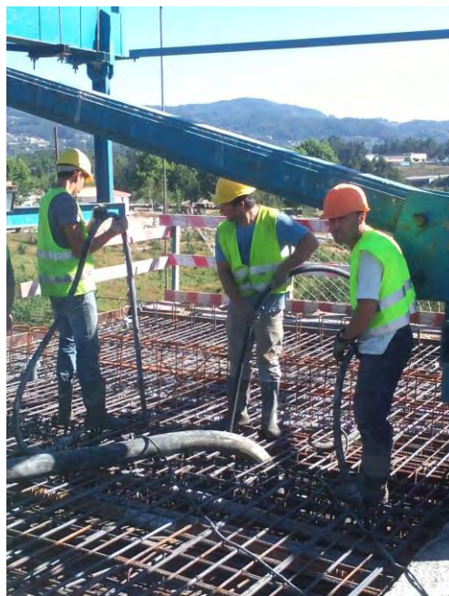
Figura 77 - Trabalhadores a realizar a vibração do betão
