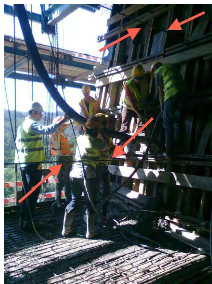
Figura 52 – Travamento da cofragem exterior
