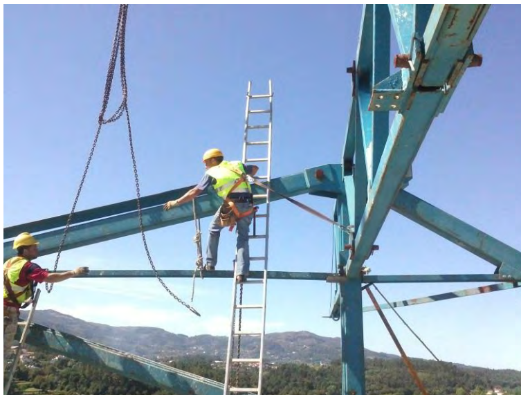
Figura 31 - Manuseamento da treliça principal
