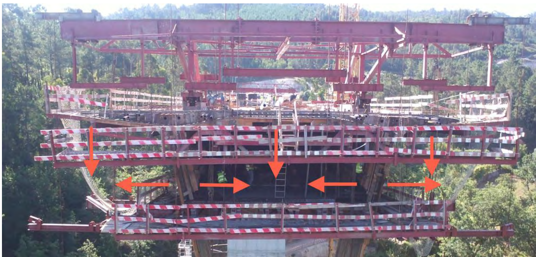
Figura 78 - Movimentação da estrutura de cofragem no processo de descofragem
