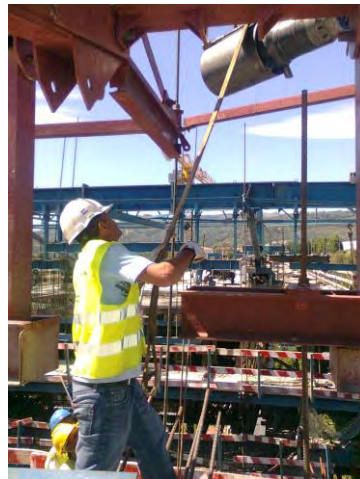
Figura 83 – Transporte do macaco hidráulico munido de corda guia
