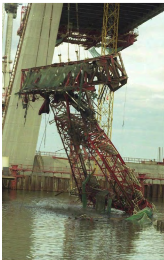
Figura 18 - Estrutura a ser retirada do Rio Tejo
