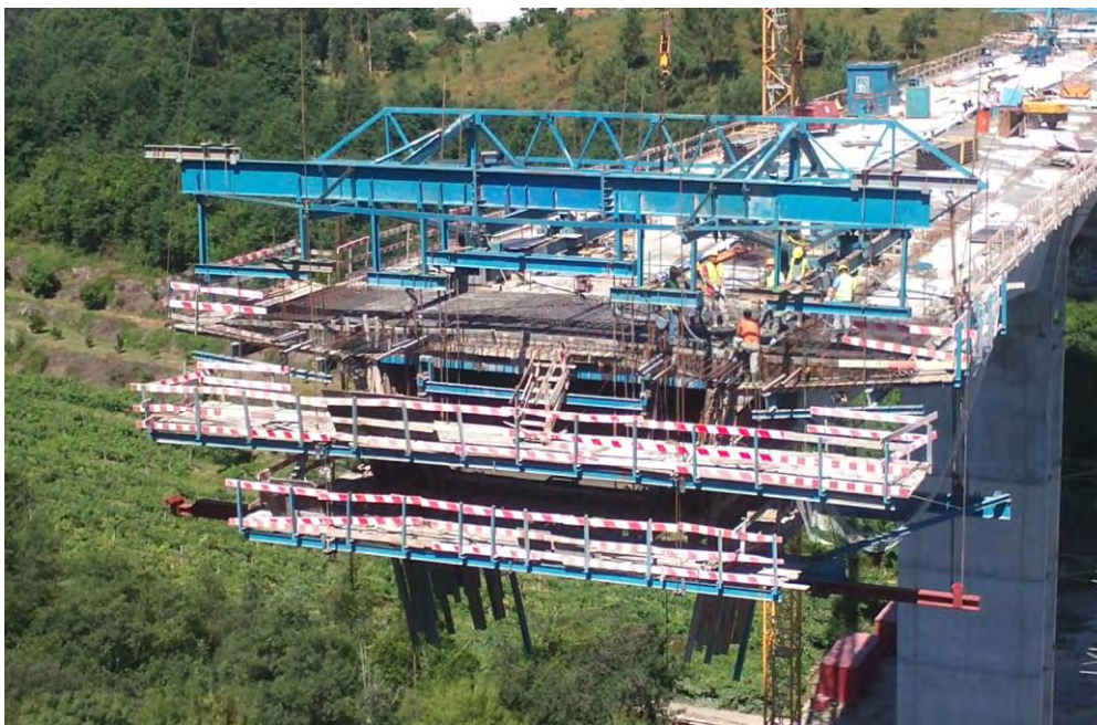
Figura 43 - Zona de trabalhos munidas de guarda-corpos
