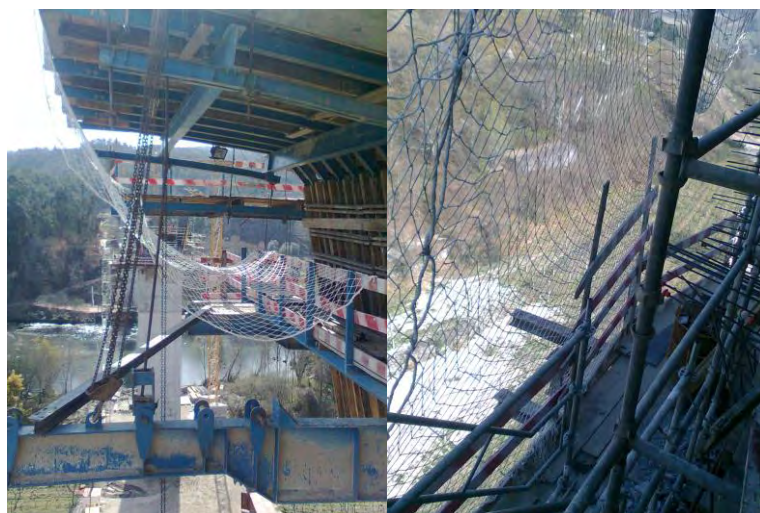
Figura 55 - Redes de segurança montadas nos C. A.
