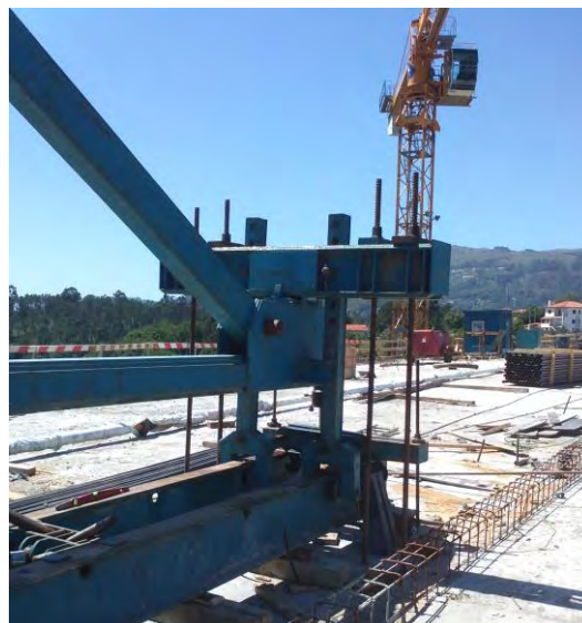
Figura 39 – Ancoragem traseira do C.A.
