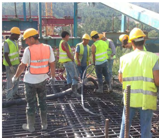
Figura 73 - Trabalhador a manusear a manga de descarga
