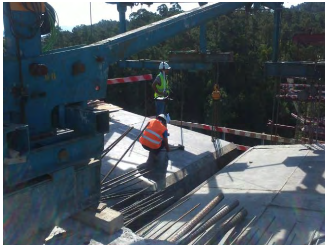
Figura 46 - Trabalhadores munidos de EPI em tarefas de cofragem
