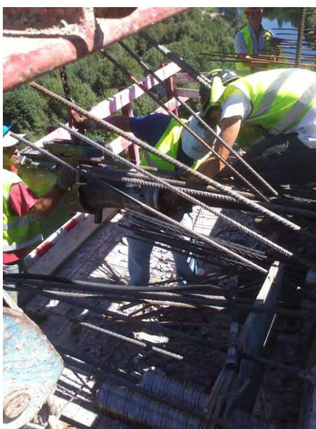
Figura 81 – Zona de trabalhos de pré-esforço no exterior munida de guarda-corpos
