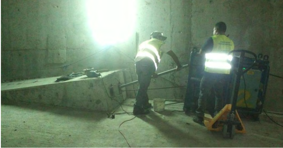
Figura 88 – Trabalhadores a instalar cabos de pré-esforço no interior da viga caixão
