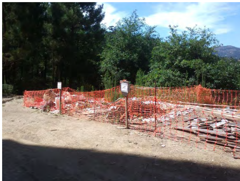
Figura 27 - Zona de separação de resíduos: madeira, sucata e plásticos
