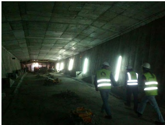
Figura 40 - Interior da viga caixão devidamente iluminado (aduelas)
