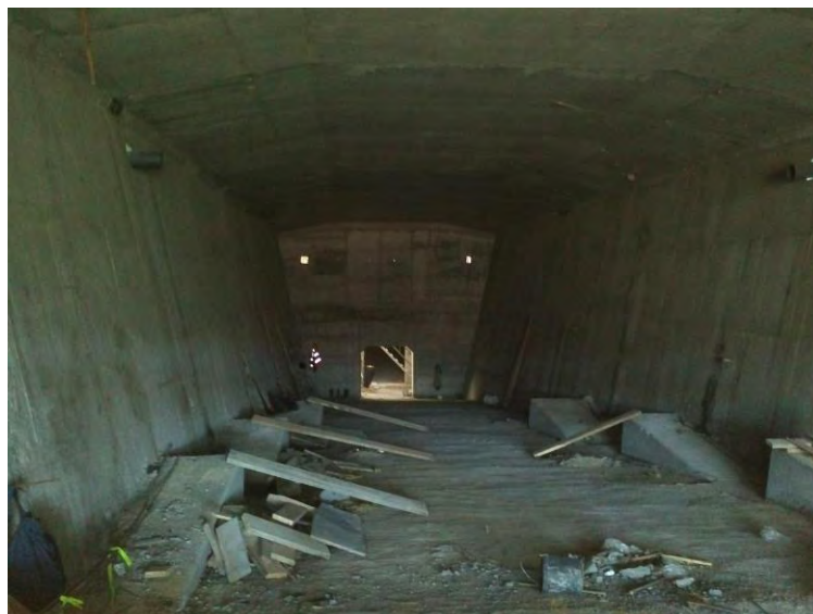
Figura 25 - Interior da viga caixão organizado (aduelas)
