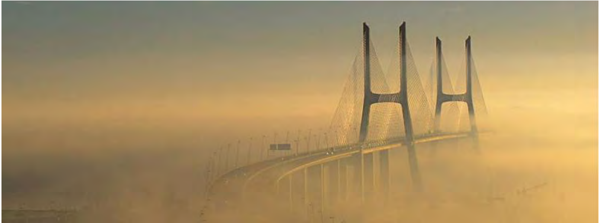
Figura 13 - Ponte Vasco da Gama
