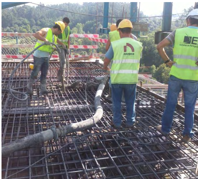
Figura 68 - Trabalhos de betonagem com guarda-corpos na sua periferia
