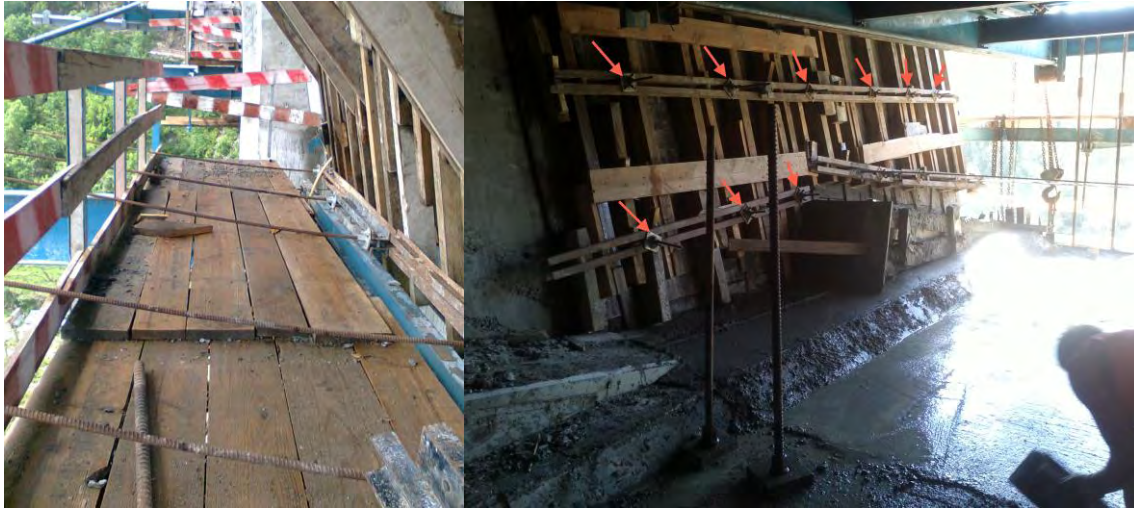
Figura 51 - Painéis de cofragem devidamente travados aquando da betonagem A cofragem exterior conta ainda com o travamento feito por varões que atravessam as almas da viga de uma ponta a outra, evitando que esta se abra.
