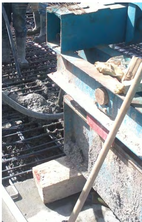
Figura 42 - Nivelamento com calços de madeira em bom estado de conservação. Este ponto é focado na “ Lista de verificação: execução de aduelas recorrendo a carros de avanço ” (Anexo IV).
