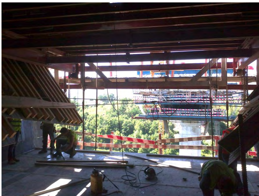
Figura 48 - Apoio da cofragem interior com corda
