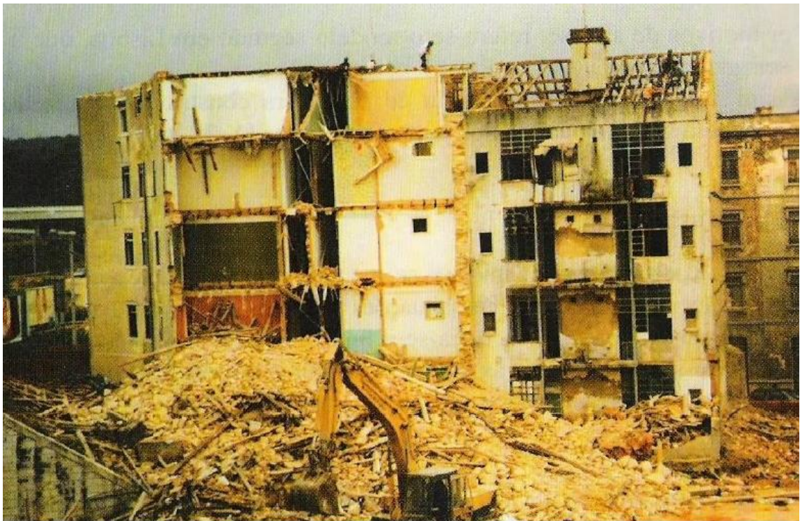
Figura 3.1 - Demolição tradicional (Fonte: Couto et al. , 2006)
