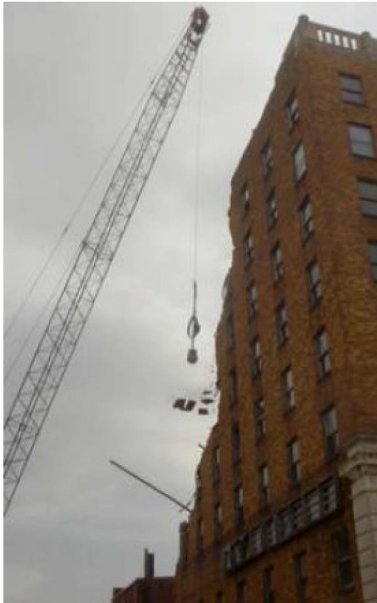
Figura 2.4 - Demolição recorrendo a bola de aço (Fonte: Costa, 2009)
