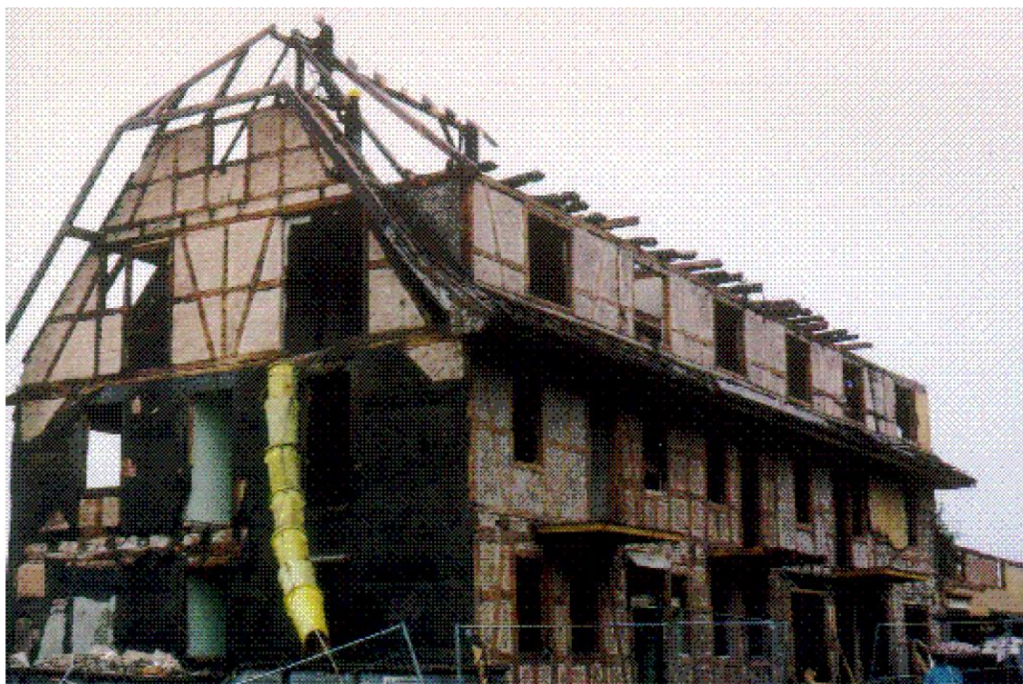
Figura 4.2 - Desconstrução do hotel em Dobel (Fonte: Schultmann, 2000)
