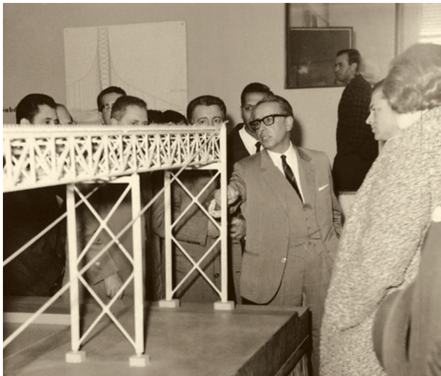
Mercier Marques numa visita da Secção Regional de Lisboa às obras da Ponte sobre o Tejo.
