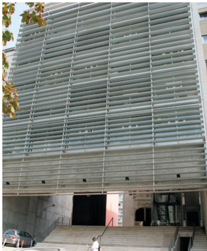
Fachada da parte nova do edifício da Ordem dos Engenheiros.
