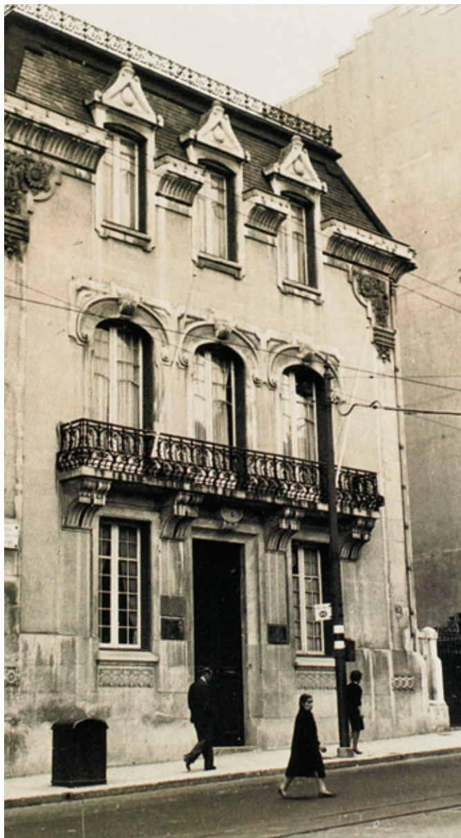
Fachada principal do edifício sede da Ordem dos Engenheiros.
