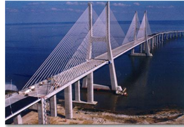
Obra de Arte/Sistema
