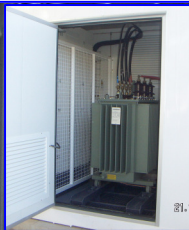
Transformador 400KVA
