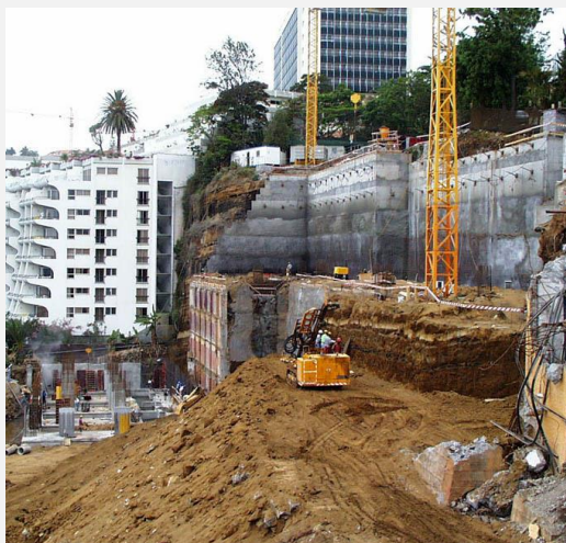
Figura 15 - Contenção com ancoragens e pregagens definitivas e revestimento de betão projetado em formações de tufos muito compactos no Hotel Savoy Royal, Funchal, 1999
