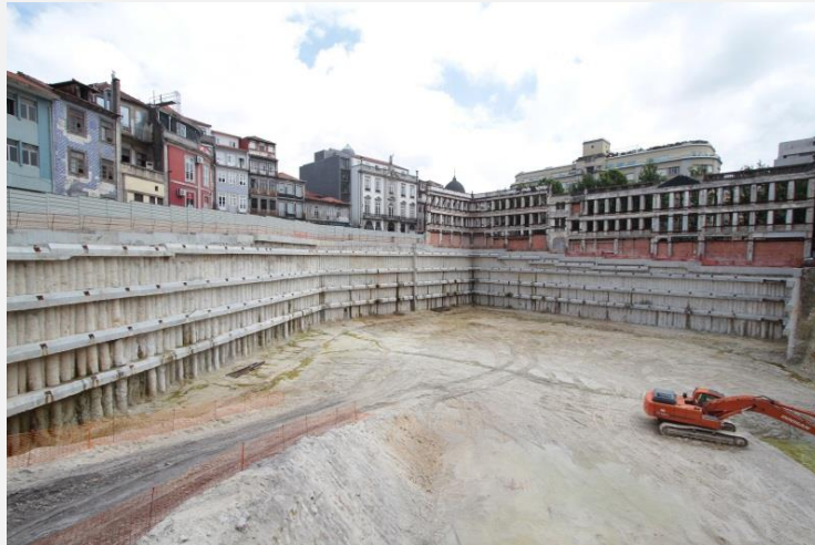
Figura 11 - Contenção de estacas moldadas secantes com 0,60 m de diâmetro, dotadas de quatro níveis de travamento através de vigas de distribuição ancoradas, para execução das caves de um edifício na Praça D. João II, Porto, 2017
