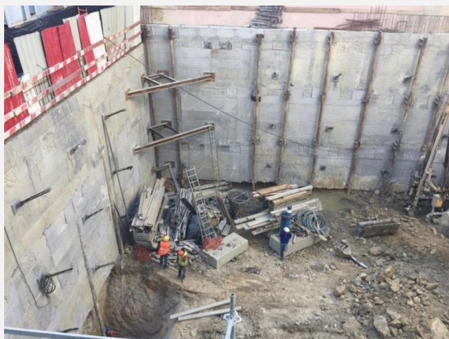
Figura 4 - Contenção tipo Berlim com 4 caves na Rua Barata Salgueiro, Lisboa, 2017
