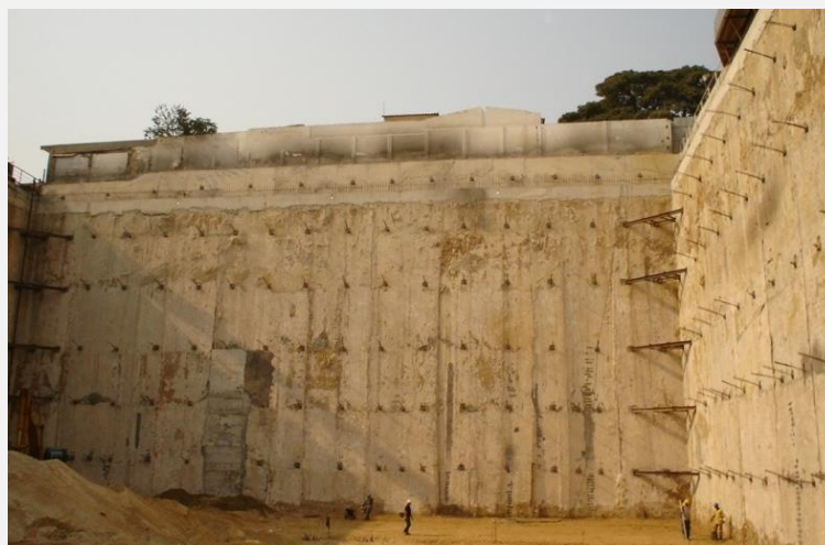
Figura 6 - Contenção com painéis de parede moldada, com espessura de 0,50 m, ancorados em 6 níveis em edifício de escritórios em Luanda, 2005
