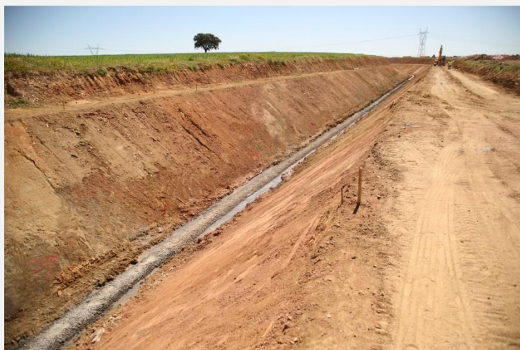
Figura 3 - Escavação de vala à custa de taludes
