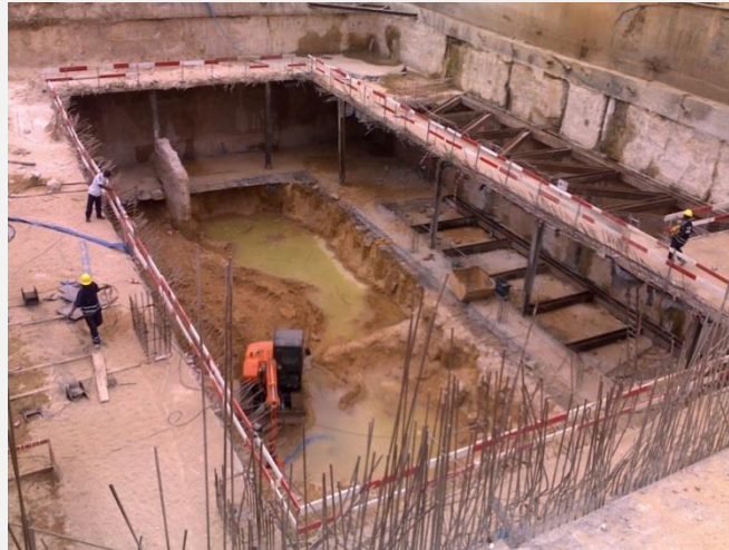
Figura 8 - Contenção de 5 pisos com painéis de parede moldada, escorados pelas lajes dos pisos, no edifício Baía, Luanda, 2018
