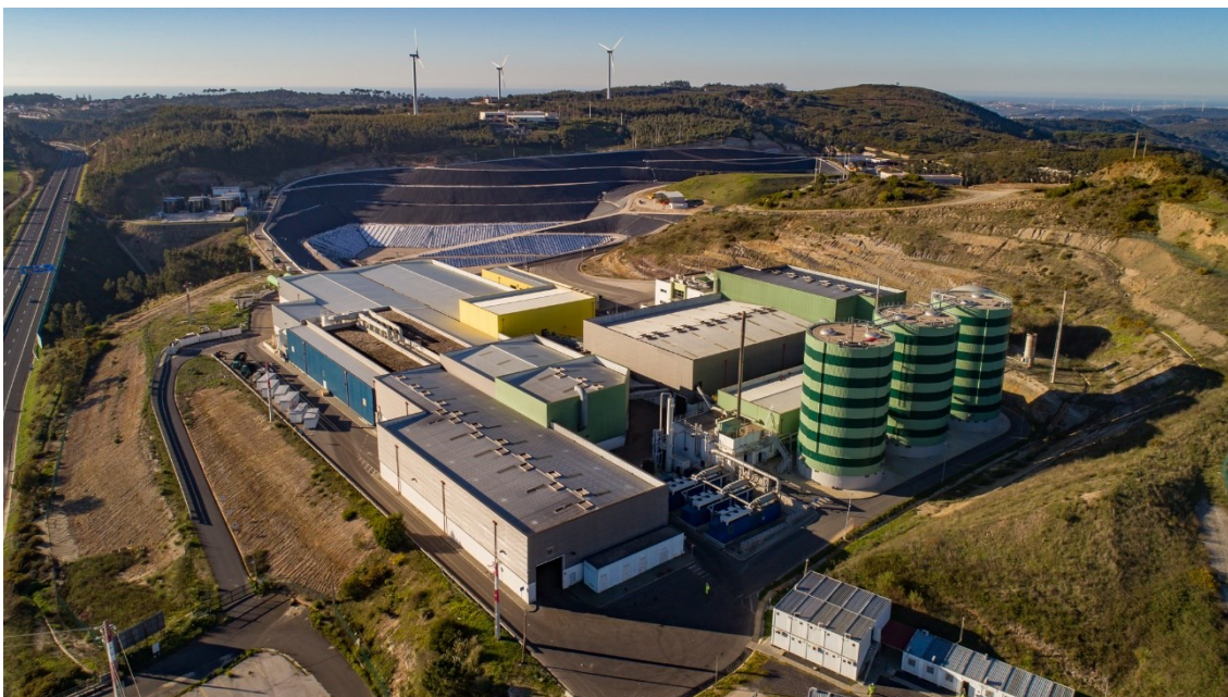
Vista geral do complexo industrial da empresa em Mafra, com os 3 biodigestores em primeiro plano
