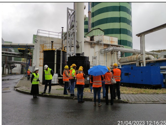
Visita centro eletroprodutor de aproveitamento do biogás da DA
