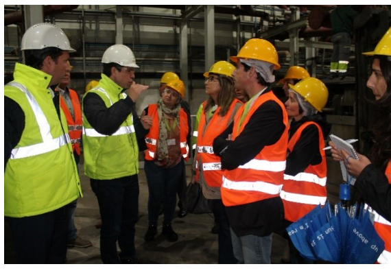
Explicação técnica do funcionamento e das tarefas diárias na alimentação dos digestores, a manutenção das bombas os processos de desidratação com tamisadores e bombas centrífugas, pelo Diretor da Unidade da Abrunheira, Eng o Ricardo Castro
