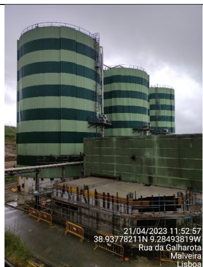
Vista dos 3 bioreatores de digestão anaeróbia
