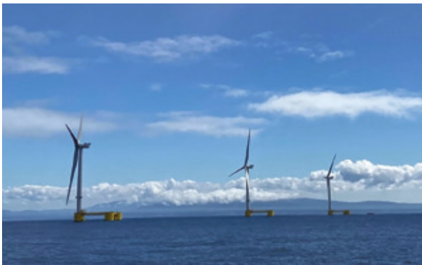
Figura 1 WindFloat Atlantic: primeiro parque eólico offshore flutuante semissubmersível do Mundo
