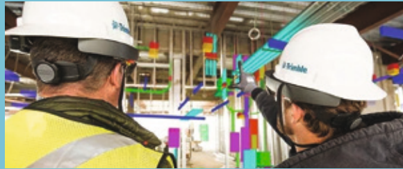
Figura 1 Realidade Aumentada em obra
